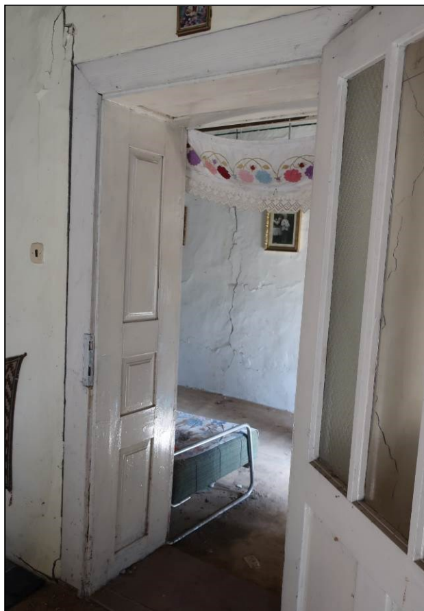
29 Obložková zárubňa interiérovej historickej dvernej výplne – detail
