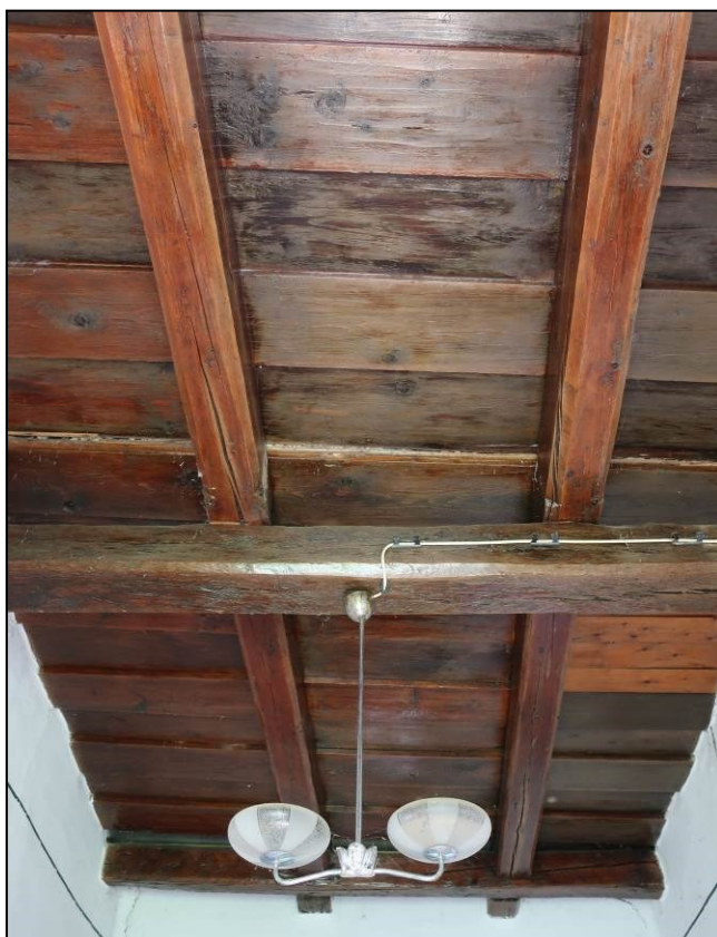
11 Drevený trámový strop s prekladaným dreveným záklopom pitvora
