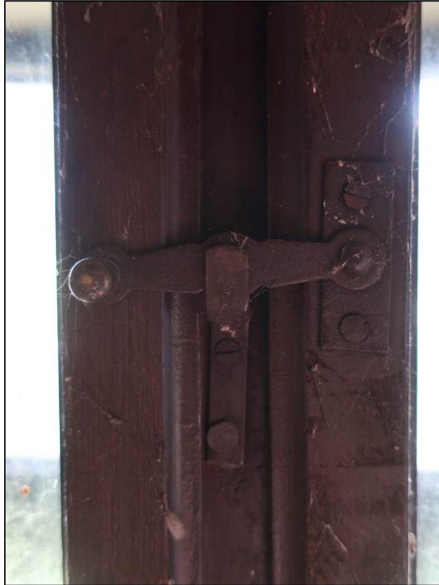
22 Obrtlík spodných krídel historickej okennej výplne – detail
