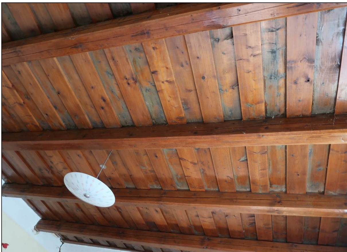
14 Drevený trámový strop s prekladaným dreveným záklopom zadnej izby
