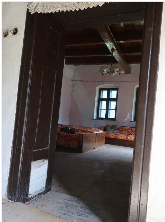
27 Obložková zárubňa interiérovej historickej dvernej výplne – detail
