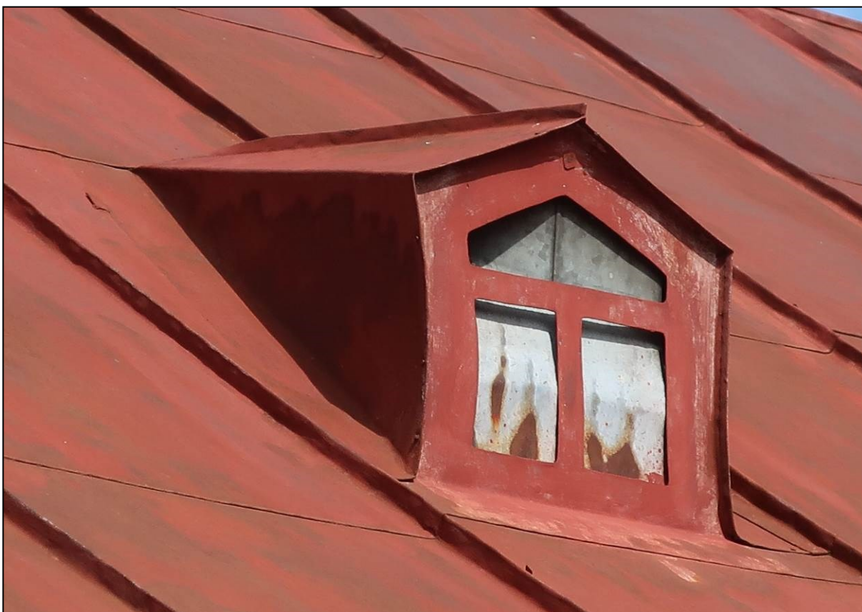
17 Presvetľovací otvor (vikier) strechy – detail
