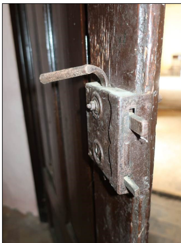
25 Krabicový zámok historickej dvernej výplne – detail
