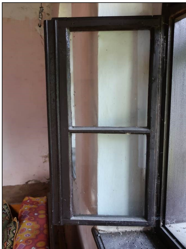
20 Spodné krídlo historickej okennej výplne – detail
