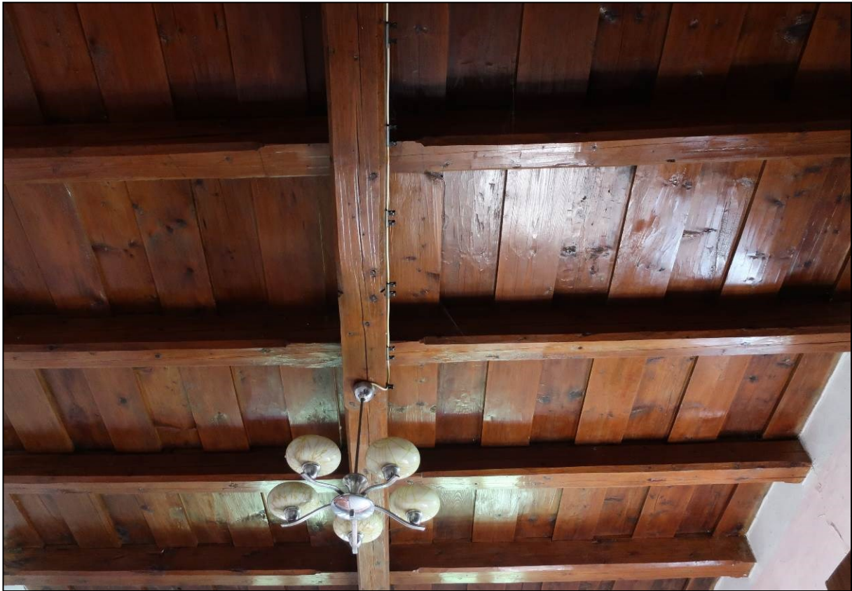
08 Drevený trámový strop s prekladaným dreveným záklopom prednej izby
