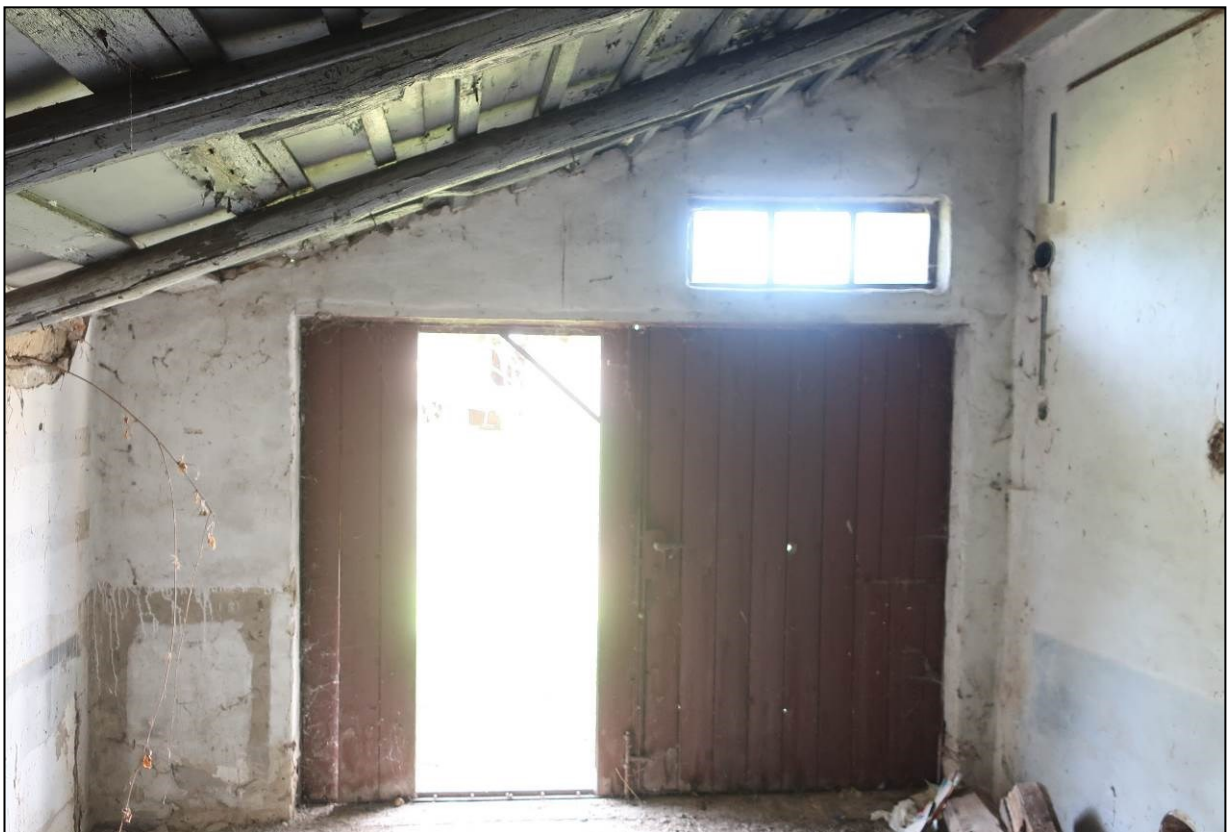
09 Novodobá prístavba – pohľad z JV
