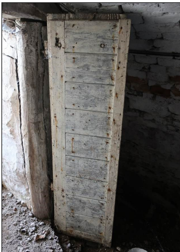
16 Severné krídlo historickej dvernej výplne - pohľad z exteriéru
