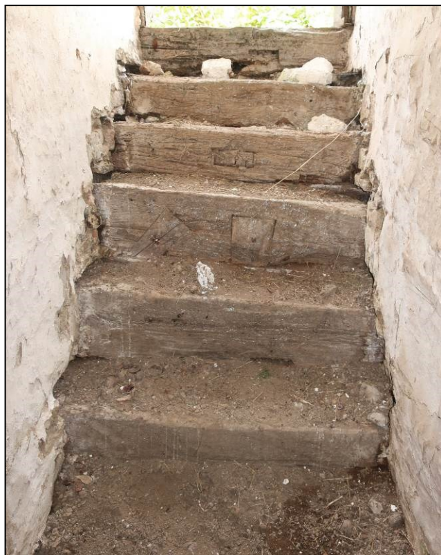
14 Drevené stupnice schodiska
