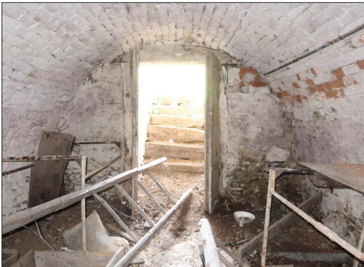
06 Pivnica – pohľad z JV
