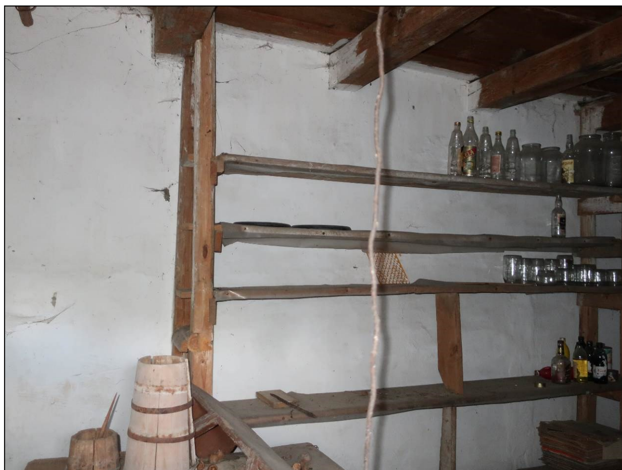
11 Interiér sypanca – pohľad zo SV
