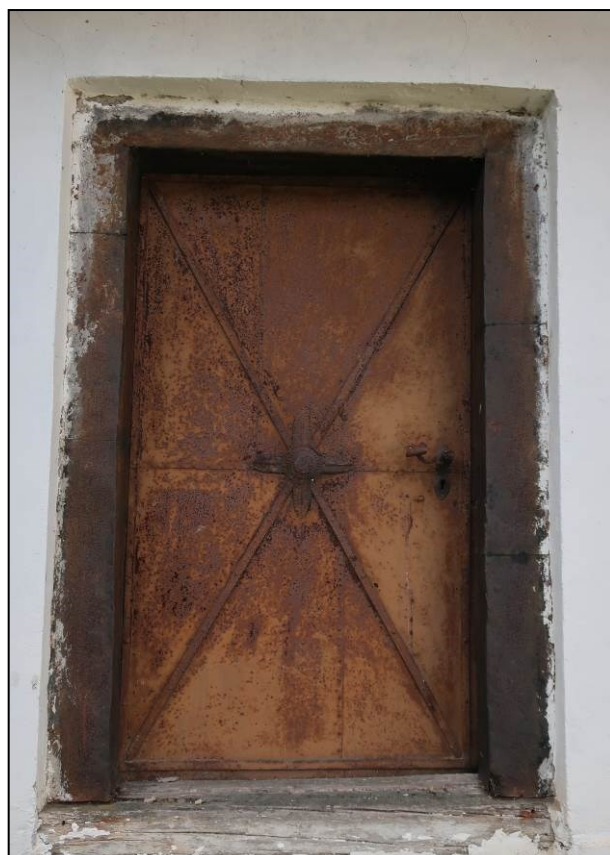
17 Historická dverná výplň s historickou výplňou hlavnej (SV) fasády
