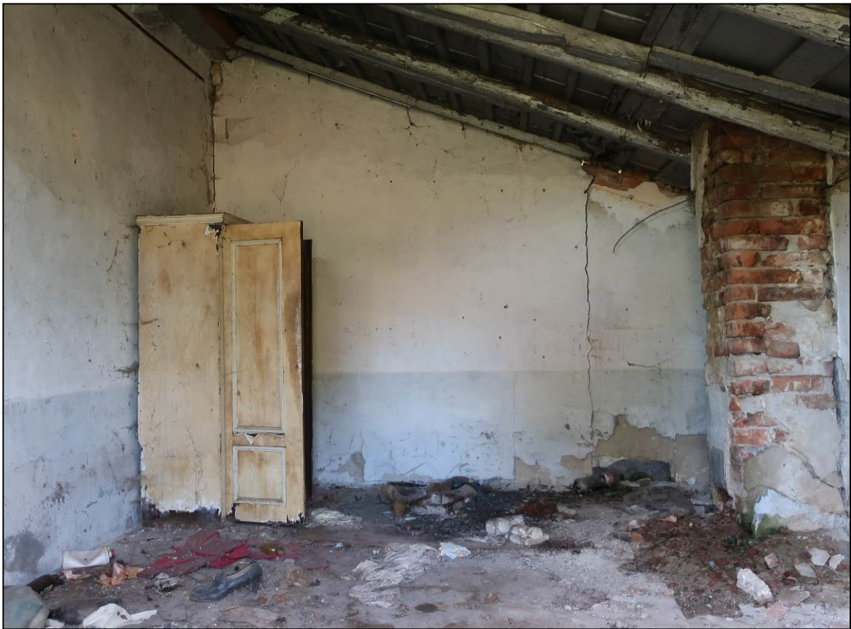
08 Novodobá prístavba – pohľad zo SZ
